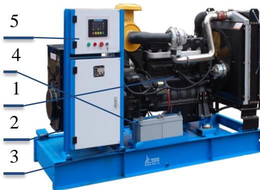
**1)Дизельный двигатель** с непосредственным впрыском топлива и водовоздушным охлаждением, с турбокомпрессором и регулятором частоты вращения; Установленным навесным оборудованием и оборудован системами обеспечения.
